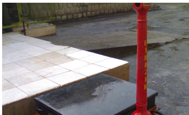
شکل شماره ۱: محل نصب باسکول جلوی سردخانه برای توزین زباله
